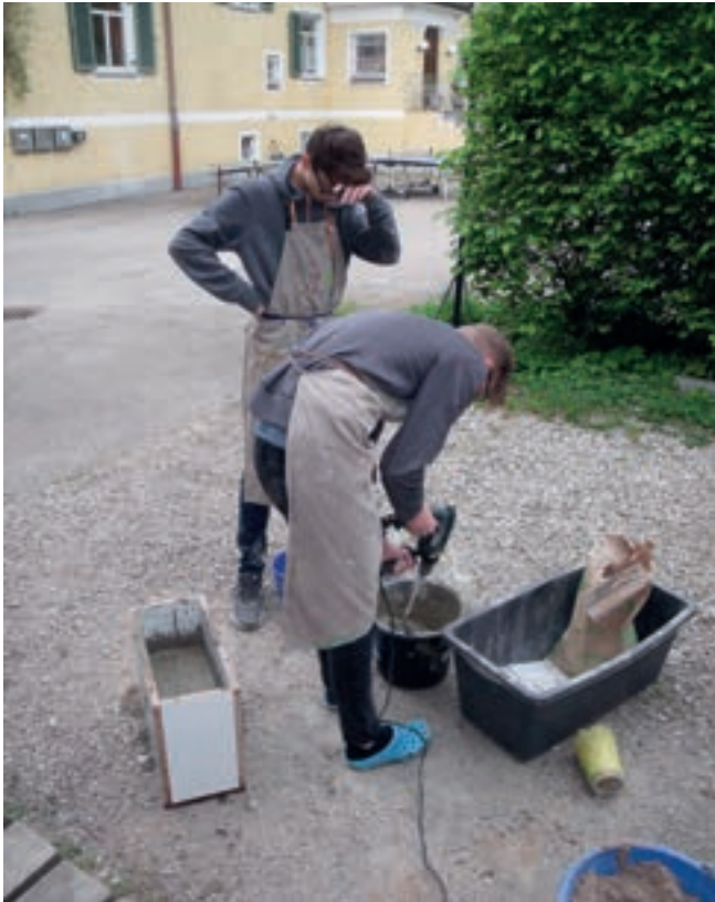
Betonieren der Klötze
