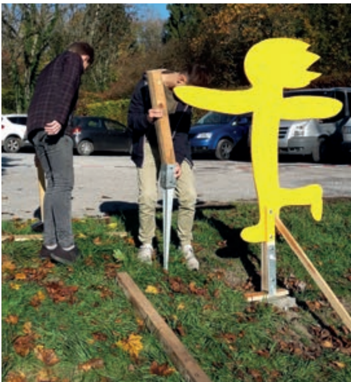
Setzen der Hülsen für die Balken der Rahmen
